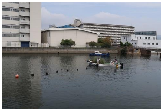
粗朶の設置作業風景（後方は警戒船）
