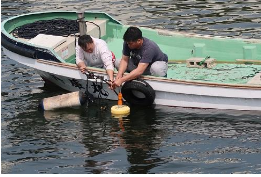
灯浮標の設置
